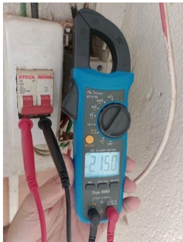
Figura 29: Medição da tensão diretamente no disjuntor de alimentação do barramento geral.
