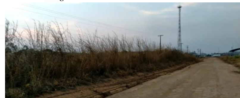
Figura 21 – Vista da rua 357 sentido BR 364
