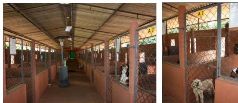
Figura 4 – Composição de imagens do bloco dos canis do Abrigo Piccolina/ Avaré-SP
