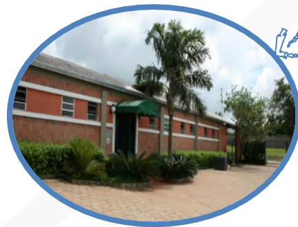
Figura 2 – Perspectiva da fachada frontal do Abrigo/Avaré-SP
