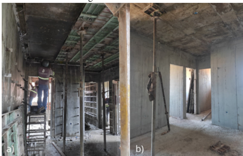
Figura 4.12 – Desforma
