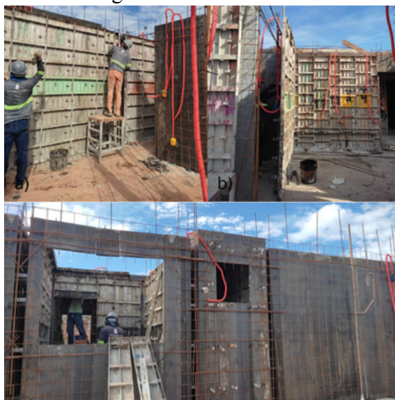
Figura 4.6 – Montagem e fechamento das fôrmas da parede
