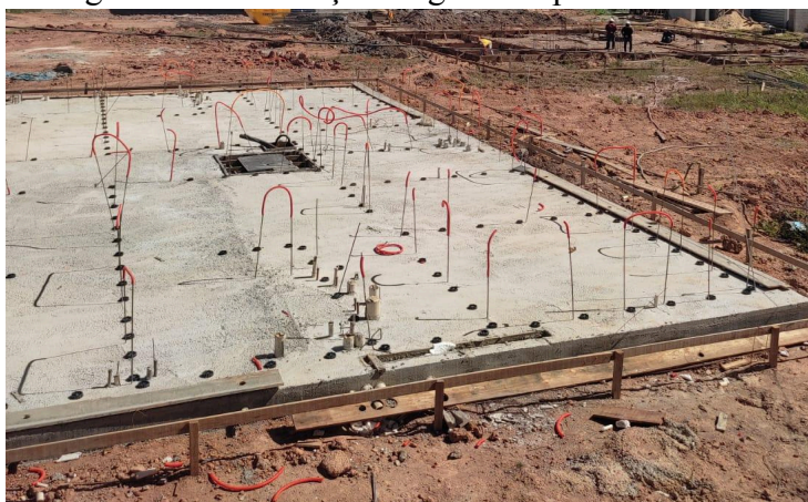
Figura 4.3 – Marcação de gabarito para as fôrmas
