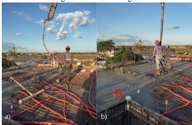
Figura 4.11 – Concretagem
