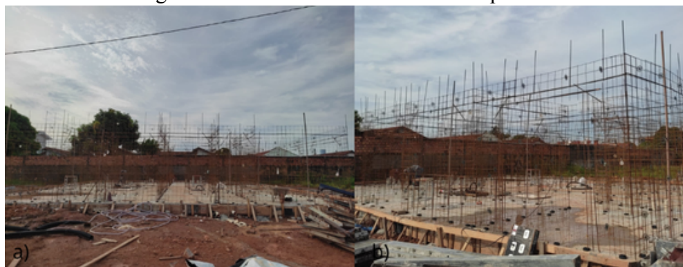
Figura 4.4 – Levantamento das telas de paredes
