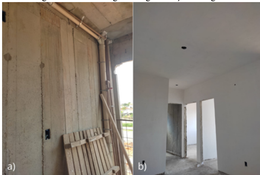
Figura 4.13 – Estucagem e regularização com gesso
