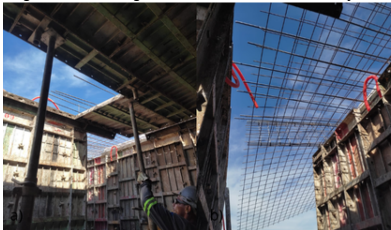
Figura 4.8 – Montagem e fechamento das fôrmas da parede
