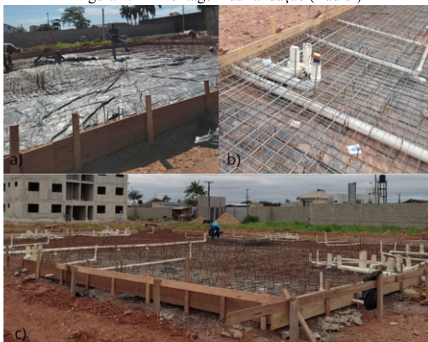
Figura 4.2 – Montagem da fundação (Radier)
