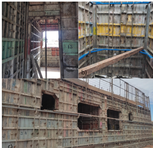
Figura 4.7 – Escoramento e travamento feito com esquadros
