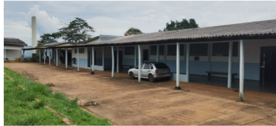
Figura 22: Cobertura e pilares
