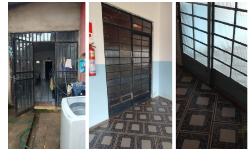
Figura 24: Porta área de serviço e porta externa refeitório
