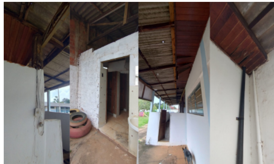
Figura 23: Forro, estrutura e cobertura
