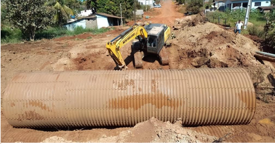
Figura 3 - Retroescavadeira fazendo os ajustes do tubo no lugar para o recebimento do aterro.
