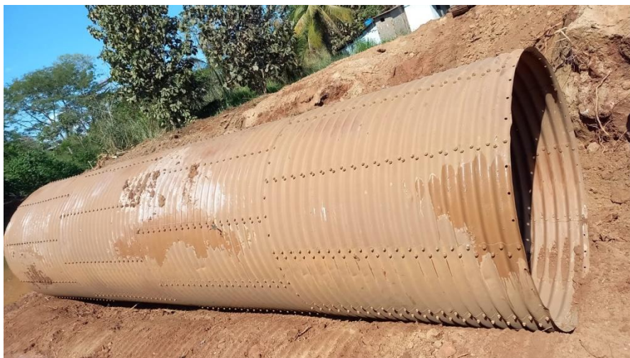
Figura 2 - Tubo de aço de 12m de comprimento sendo colocado na área previamente preparada.
