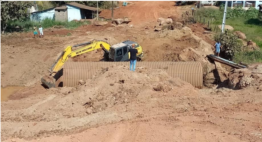
Figura 4 - Início do aterramento.
