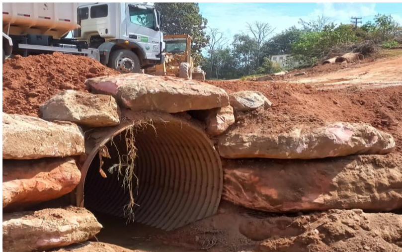
Figura 6 - Aterramento sendo finalizado
