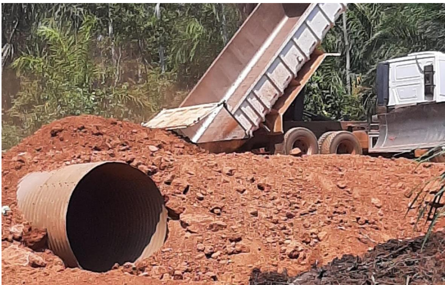
Figura 5 - Caminhões finalizando o aterramento
