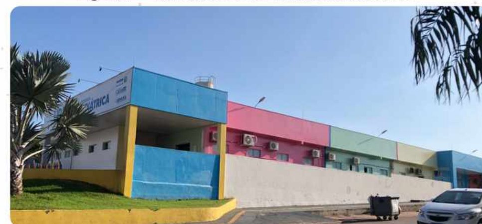
Figura 22 - Fachada UPA 24h Pediátrica de Cacoal-RO
