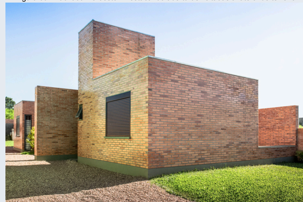
Figura 09 - Fachada Noroeste - Destacando aberturas voltadas à lateral do terreno.
