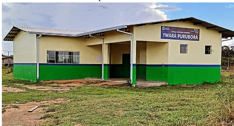
Figura 6 - Estrutura atual da Escola Ywara Purubora que se encontra em funcionamento na aldeia Aperoi.
