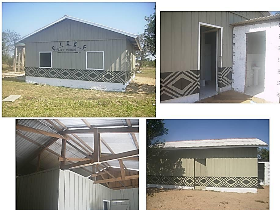
Figura 5 - Segunda estrutura da Escola Indígena Estadual de Ensino Fundamental Ywara Purubora
