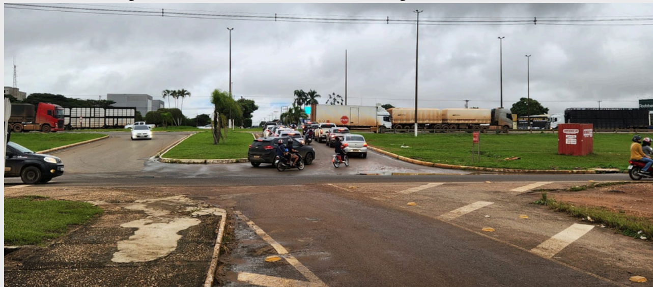
Figura 21. Cruzamento BR-364 com Avenida Brigadeiro Eduardo Gomes.
