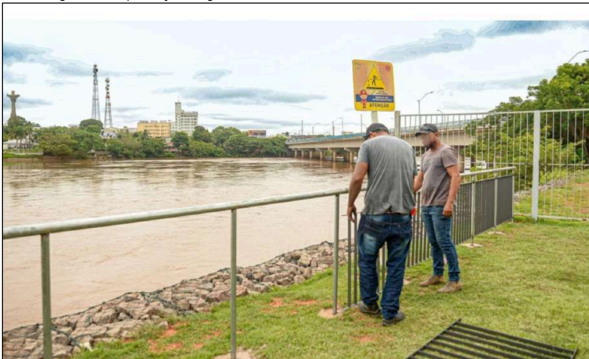
Figura 9 – Implantação do gradil na orla do Rio Machado em Ji-Paraná/RO.
