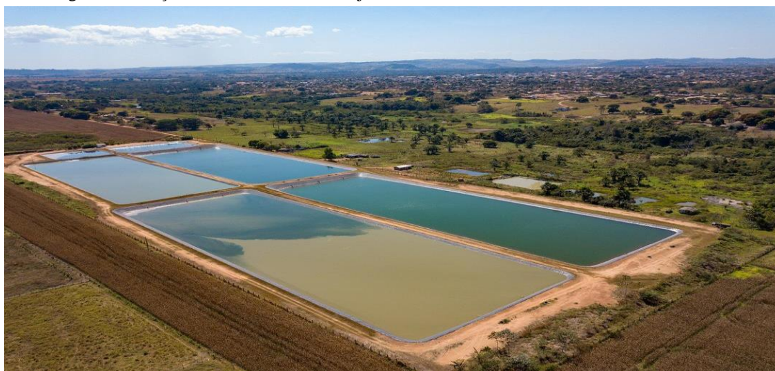
Figura 1- Lagoas da Estação de Tratamento de Cerejeiras
