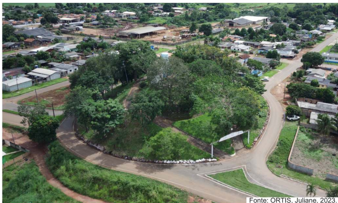
Figura 5: Pavimentação da Praça do Evangelho.
