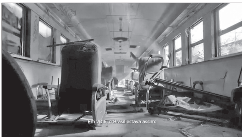
Figura 1 – Interior do trem deteriorado
