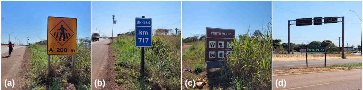
Figura 17 – Sinalização vertical na BR-364 próximo a interseção.
