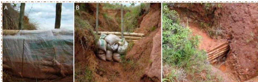
A: Representação de uma barreira revestida com sacos de rafia; B: representação de uma das barreiras com paliçadas de bambú e sacos de rafia servindo de escora; C: material fino retido nas barreiras de bambú.
