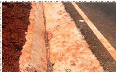
Canaleta em concreto.
