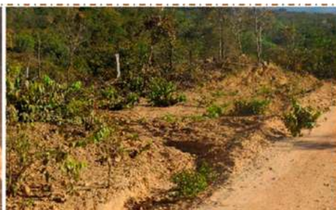
Canaleta em solo.
