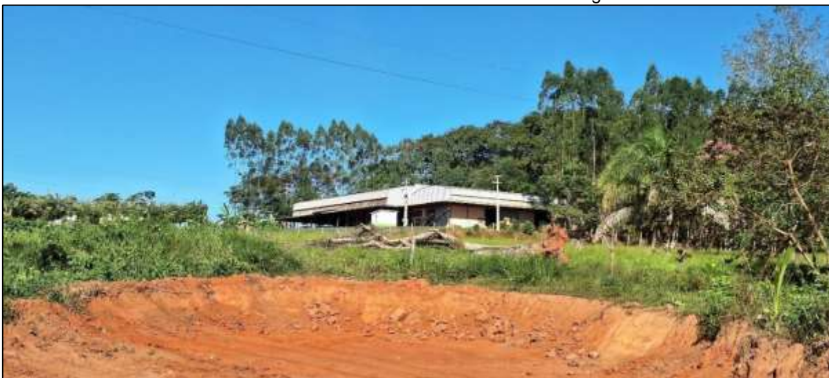
Foto 9 – Novo Horizonte do Oeste: Cafeeira instalada às margens da RO – 010
