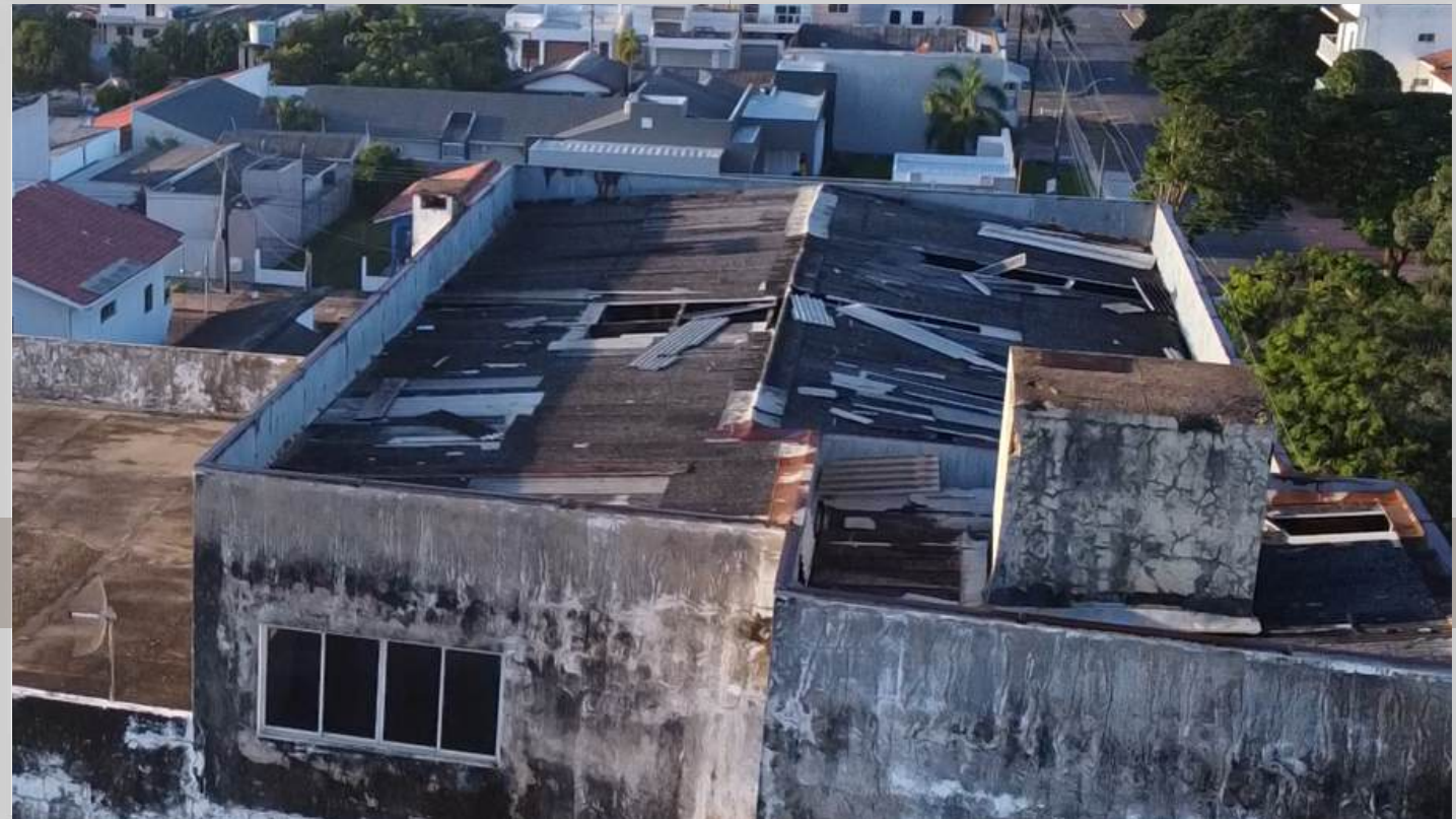
Figura 31: Vista Aérea da Cobertura
