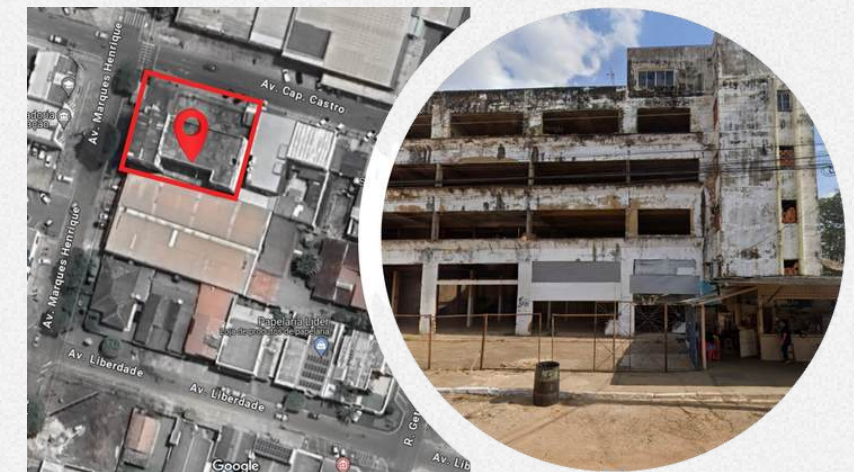
Figura 2: Fachada do edifício, início de 2024
