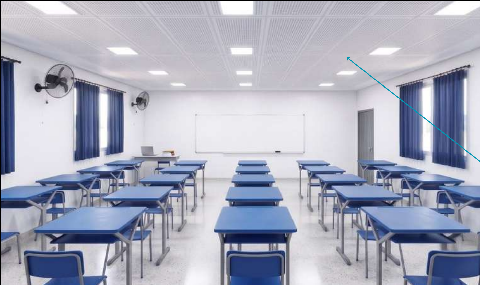
Figura 25: Forro de Gesso Acartonado de 13mm
