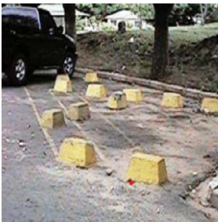
Figura 3 – Vaga para pessoa com deficiência interditada e sem pintura.
