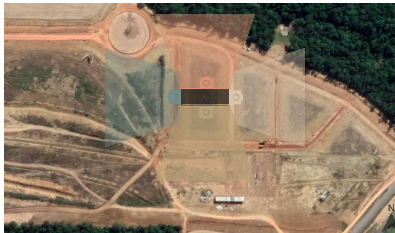
Figura 15 - Imagens do terreno
