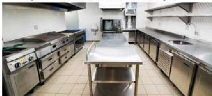
Figura 7 - Cozinha industrial - Linha de montagem
