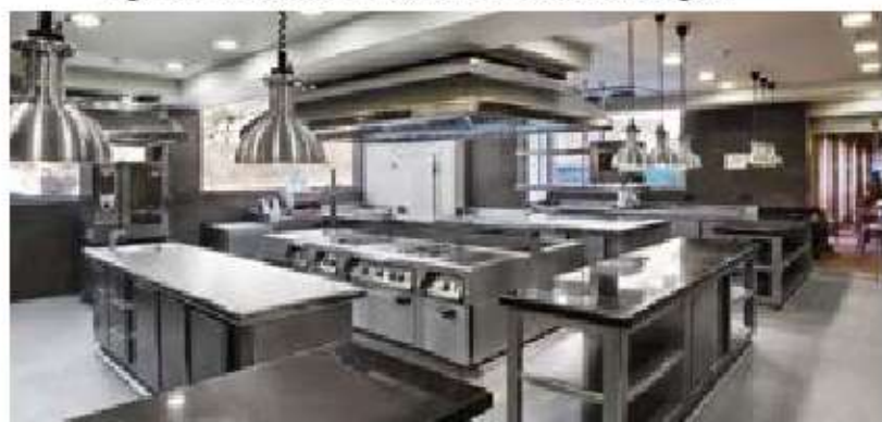
Figura 6 - Cozinha industrial - Linha de montagem
