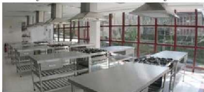
Figura 8 - Cozinha industrial - Linha de montagem
