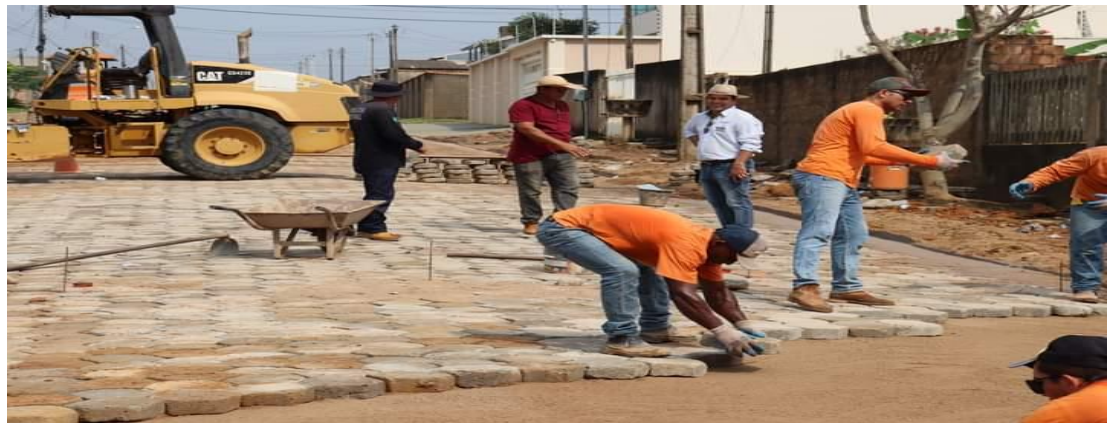
Pavimentação completa da Rua Rio Branco feita em bloquetes, com o acompanhamento do Prefeito
