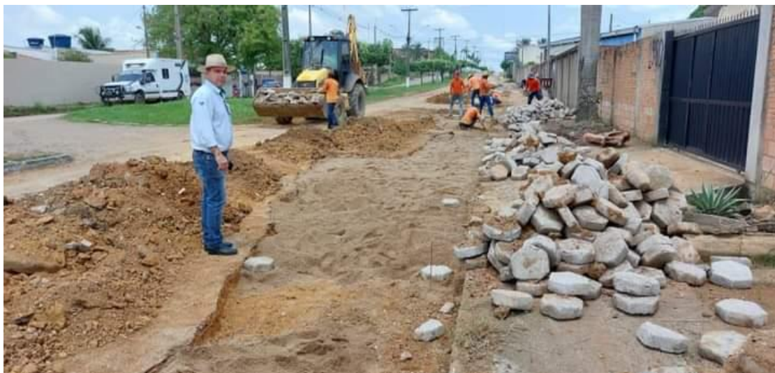
Reparo na Avenida Monte Negro com bloquetes, sendo acompanhado pelo Prefeito Roni Irmãozinho
