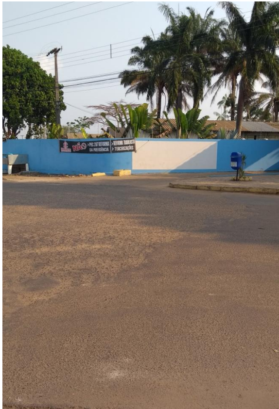
Figura 3: Travessia sem faixa em frente ao campus .
