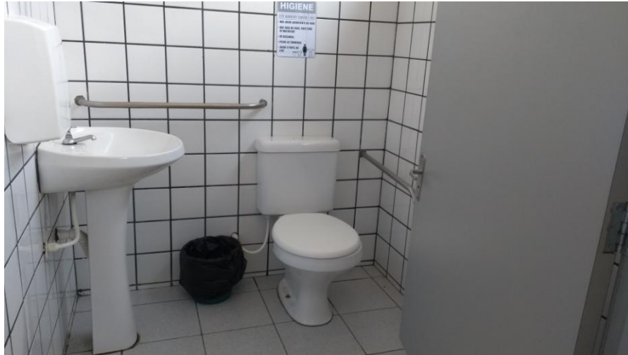
Figura 10: Banheiro para cadeirantes na Biblioteca.
