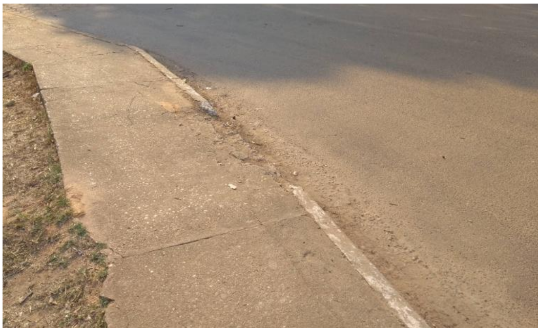
Figura 1: Rebaixamento de calçada no entorno do IFRO.
