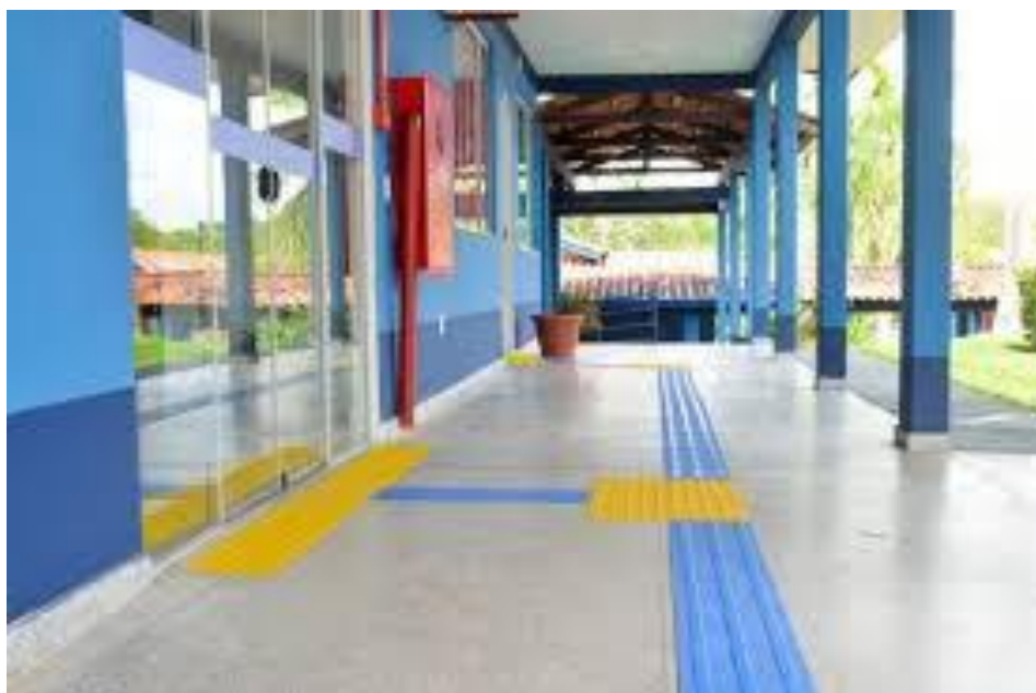
Figura 22: Sinalização tátil em escola.
