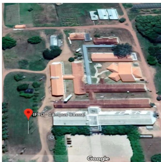
Figura 6: Vista aérea do Campus Cacoal
