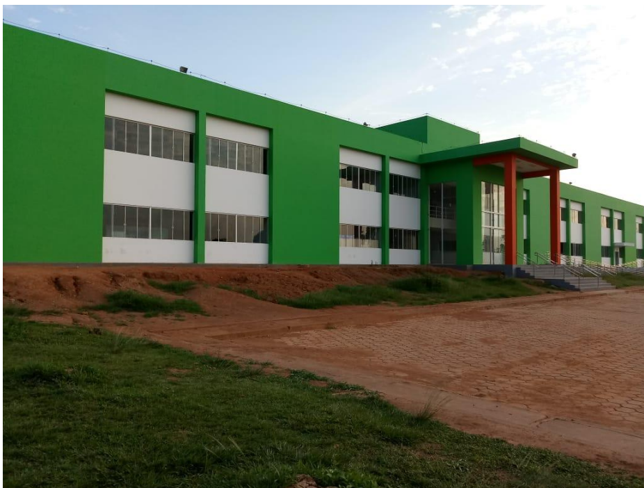
Figura 8: Prédio administrativo/fachada do campus Cacoal
