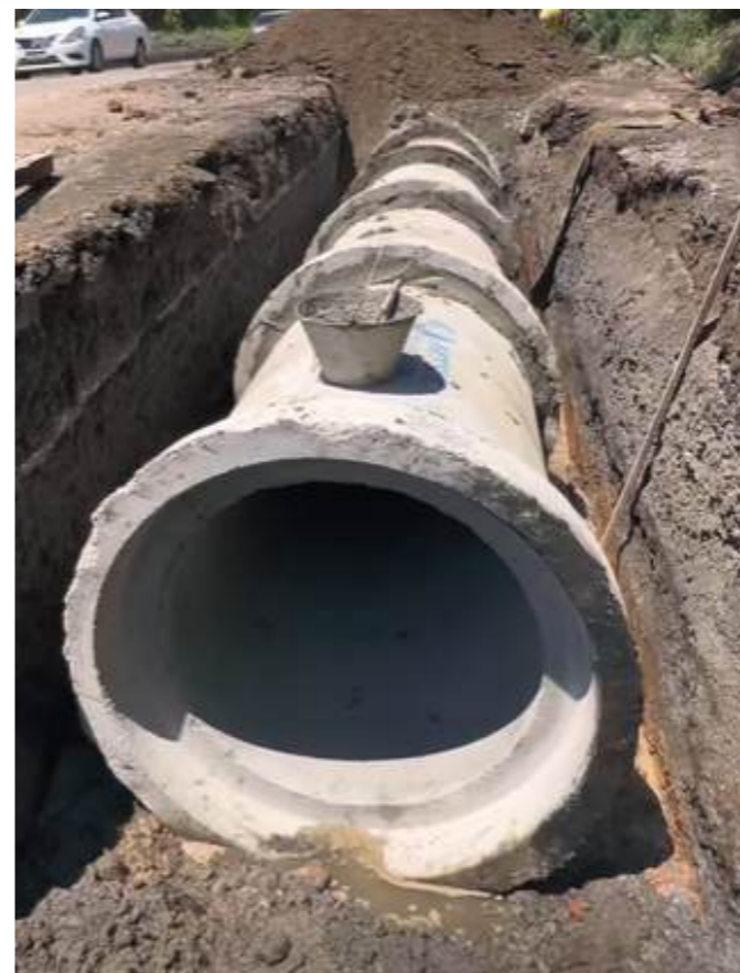
IMAGEM 33. TUBULAÇÃO PARA DRENAGEM URBANA AVENIDA ENGENHEIRO SOUZA FILHO, EM 2021. FONTE: MARCELO, 2024.
