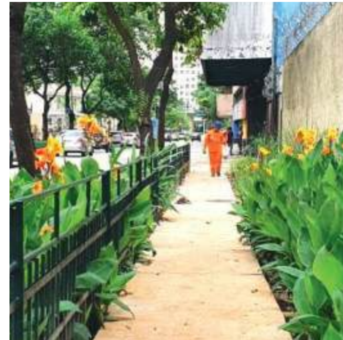
IMAGEM 17. BIOVALETAS. FONTE: ECOLOGIA, 2024.
