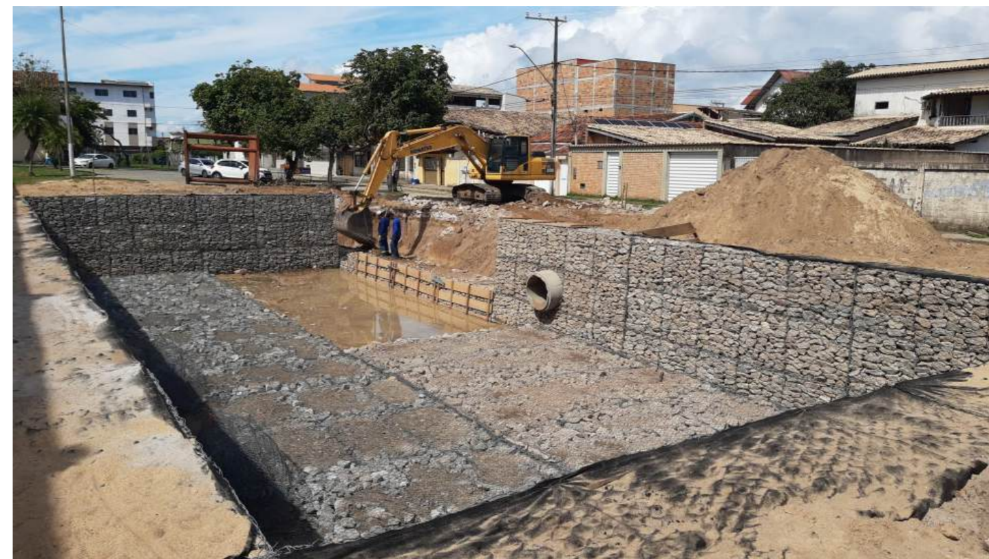
IMAGEM 07. BACIA DE INFILTRAÇÃO. FONTE: PREFEITURA, Mucuri, 2023.
