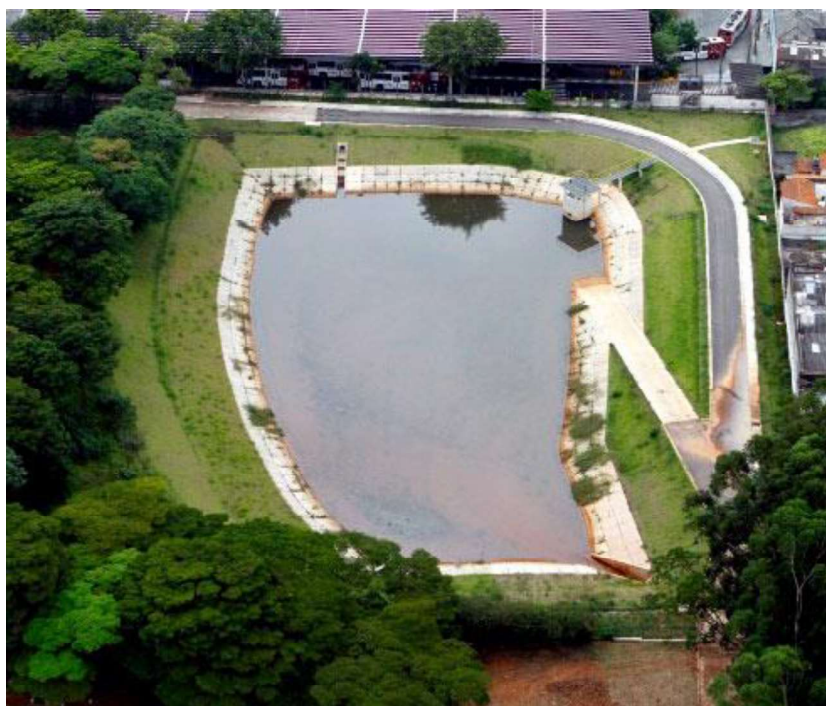
Figura 9 - Bacia de detenção
