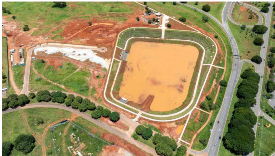
Figura 22 - Vista aérea do lago de detenção do DF
