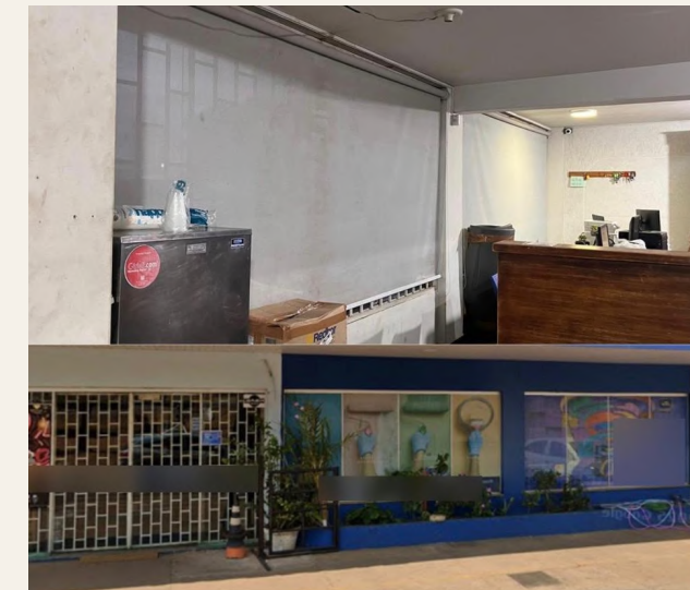
Figura 10: Esquadrias do salão comercial
