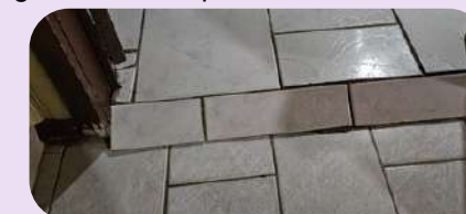
Figura 26 - Rampa inserida na residência
