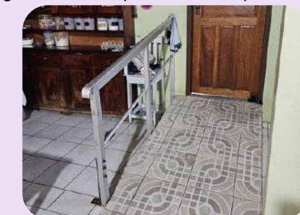
Figura 27 - Rampa construída para acesso
