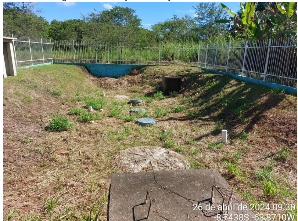
Figura 07 – Área para execução do reator UASB
