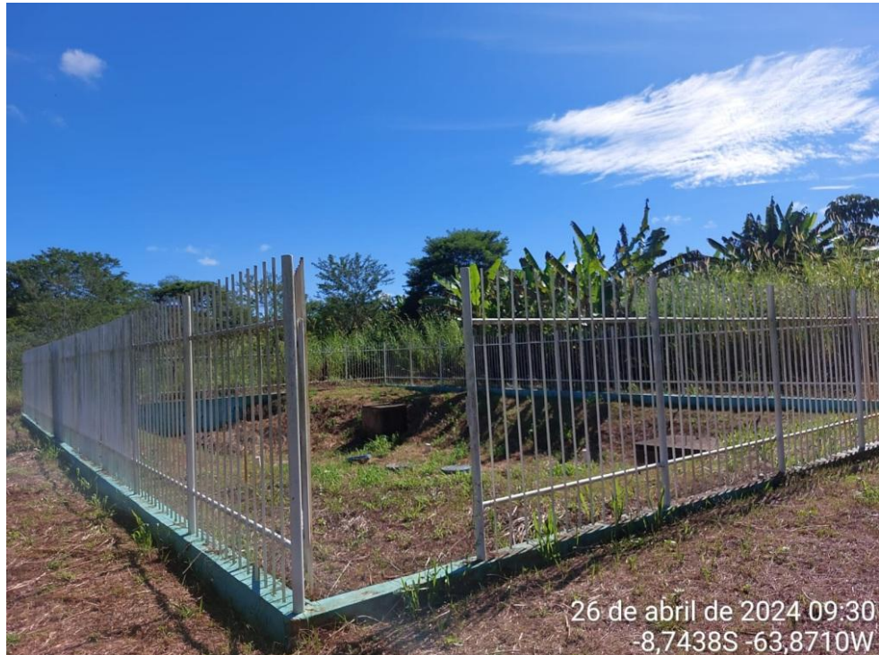
Figura 06 – Área para execução do reator UASB
