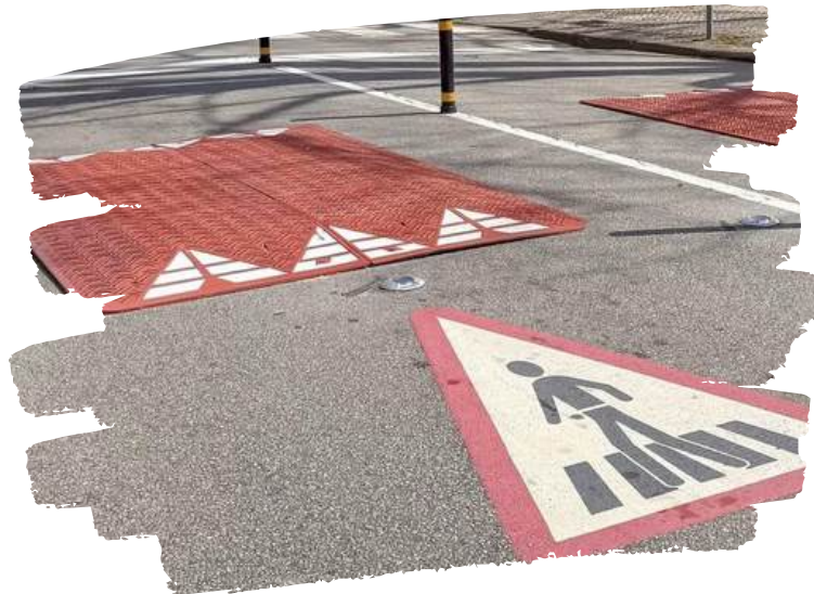
Figura 64: Almofadas são instaladas em São João da Madeira, Portugal.
