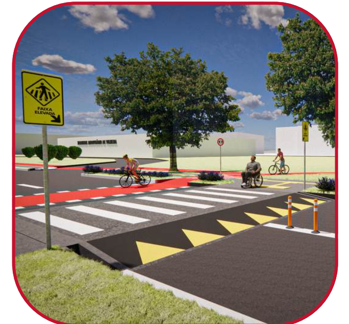
Figura 76: Travessia elevada e ciclovia
