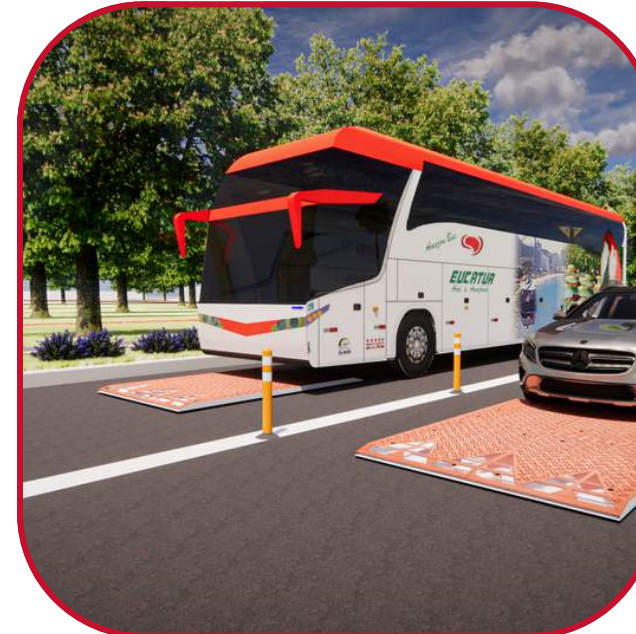
Figura 75: Almofoadas redutoras de velocidade
