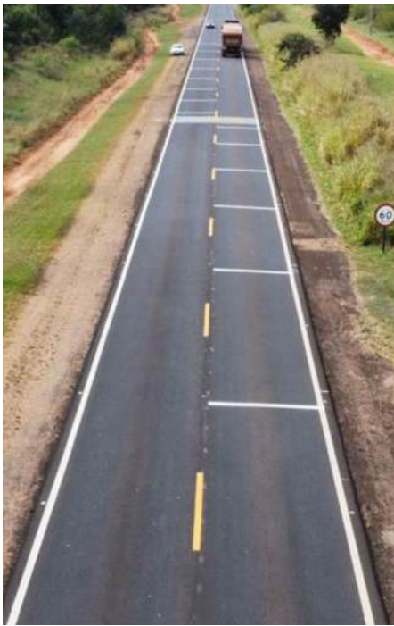
Figura 61: Linhas de estímulo à redução de velocidade na SP 613, em Teodoro Sampaio, SP.
