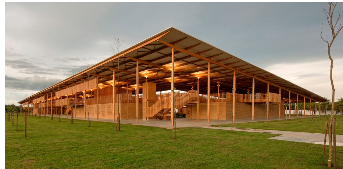
Figura 5 - Fachada Escola Canuanã
