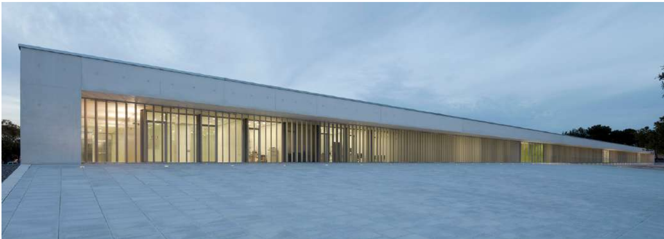
Figura 7 - Fachada Frontal do Centro de Reabilitação
