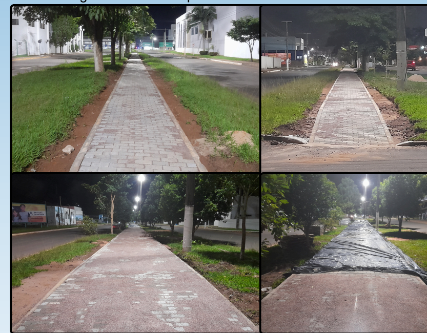
Figura 43: Obra da pista de caminhada em Vilhena
