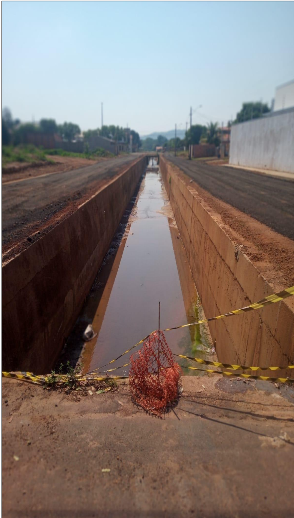
Imagem 3: Canalização na Rua Dom Pedro Primeiro
