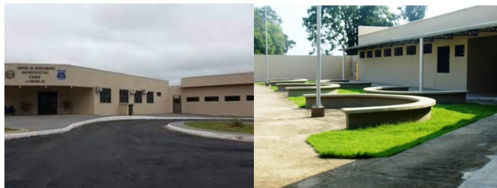
Figura 07 e 08 – Fachada da unidade e área de convivência.
