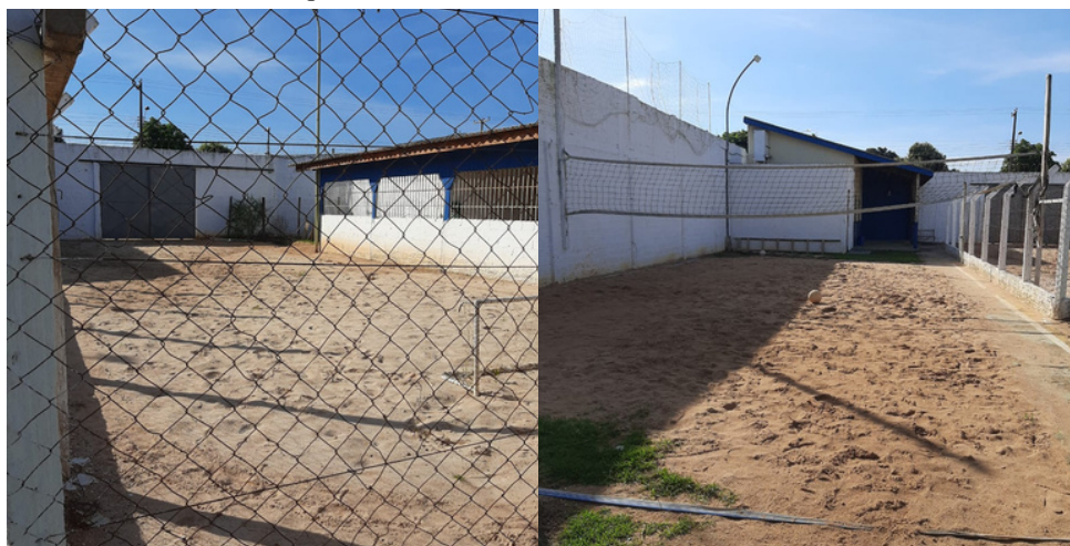
Figura 05 e 06 – Quadra de futebol e quadra de vôlei de areia sem cobertura.
