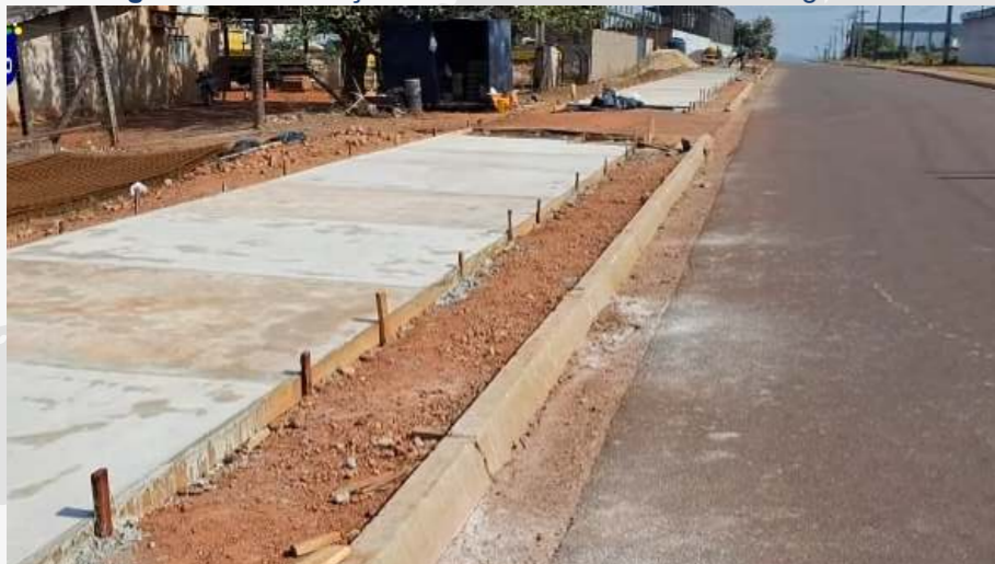
Figura 25. Construção da Ciclovia na Avenida dos Imigrantes.
