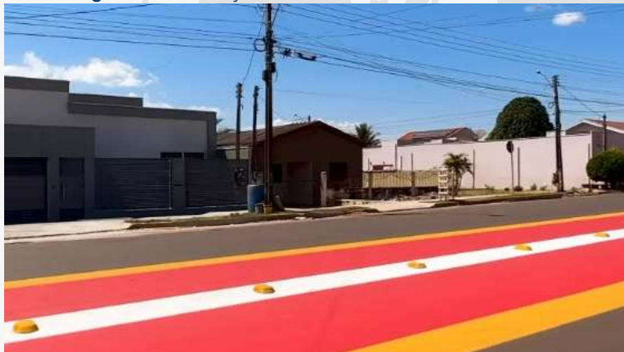
Figura 26. Construção da Ciclofaixa na Avenida Riachuelo.
