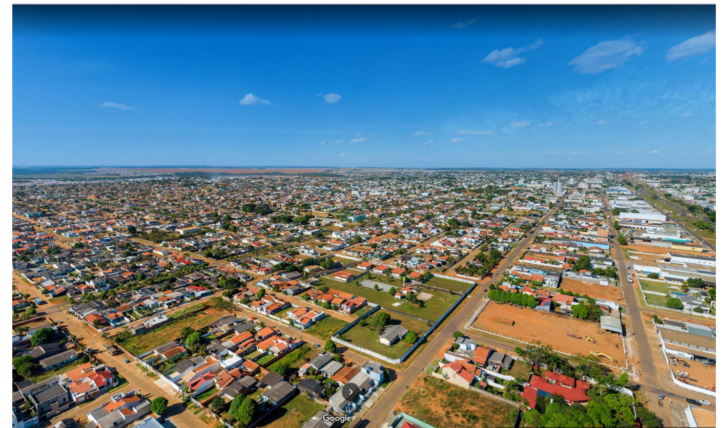
Figura 6: Vista Aérea de Vilhena – RO.
