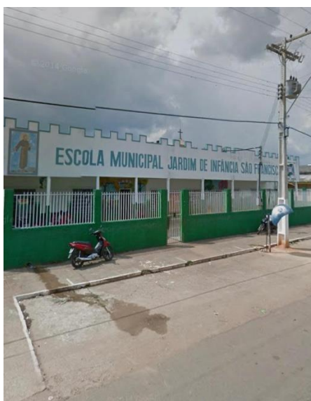
Figura 1 – Escola de realização da intervenção.
