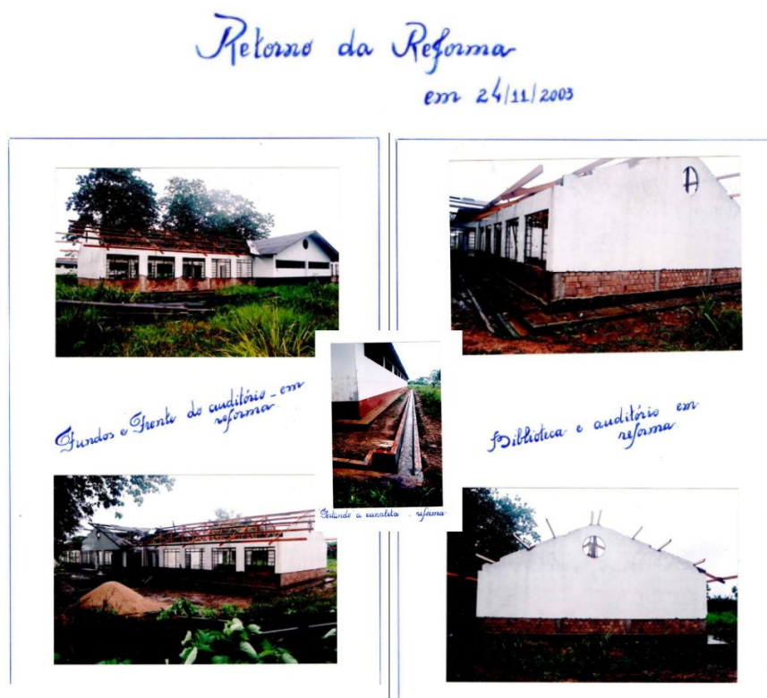
Figura 69 - Retorno da reforma, em novembro de 2003
