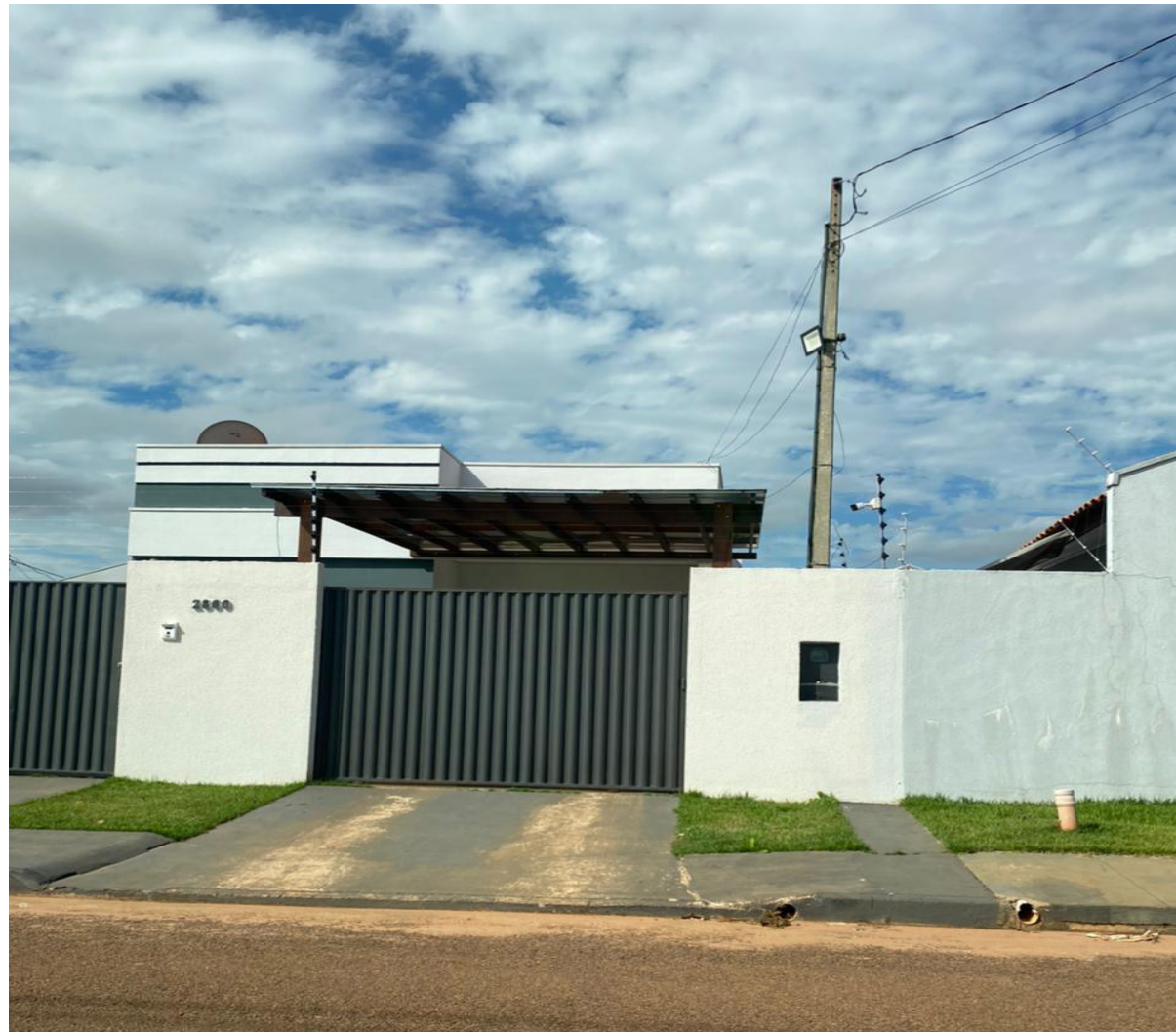
Figura 11 - Construção de garagem posteriormente em recuo.
