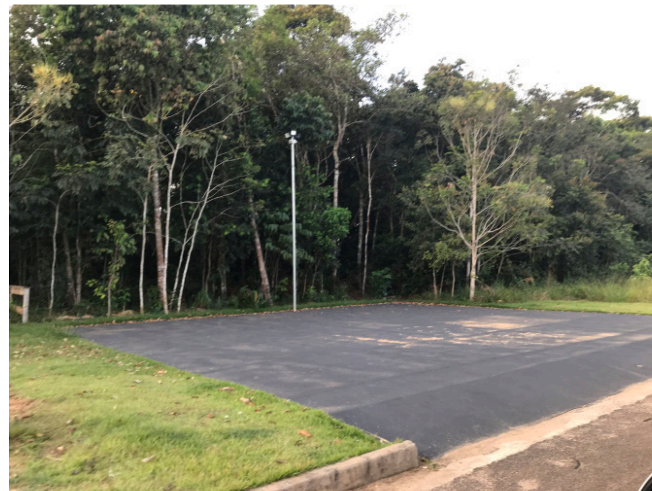
Figura 06 - Intervenção em área verde do loteamento.
