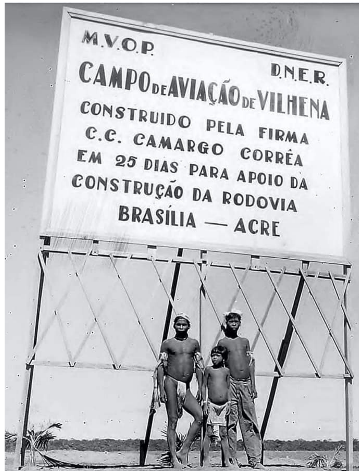
Figura 6 - Colagem, imagem da placa instalada na construção da pista de pouso.
