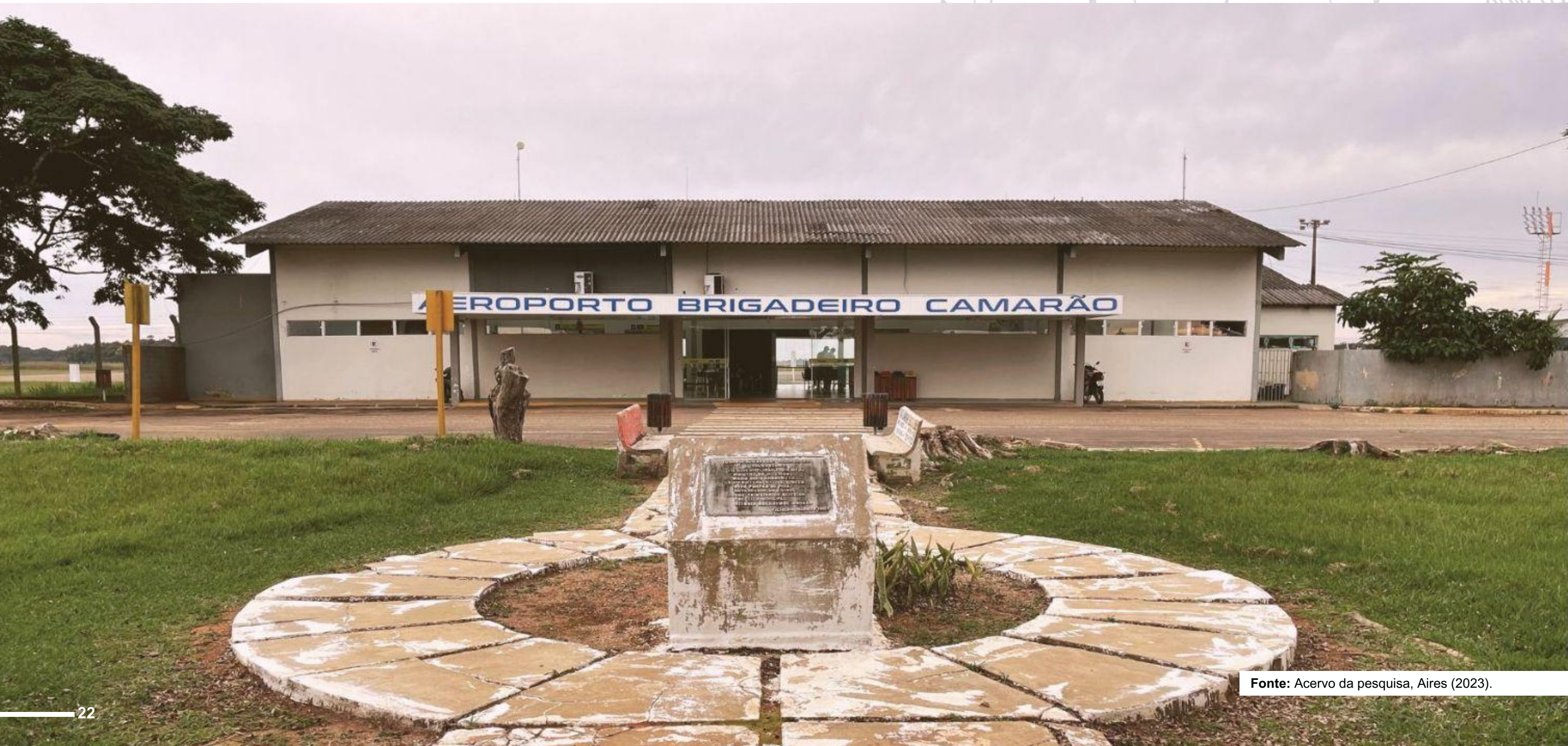
Figura 13 - Foto da fachada principal do aeroporto de Vilhena.
