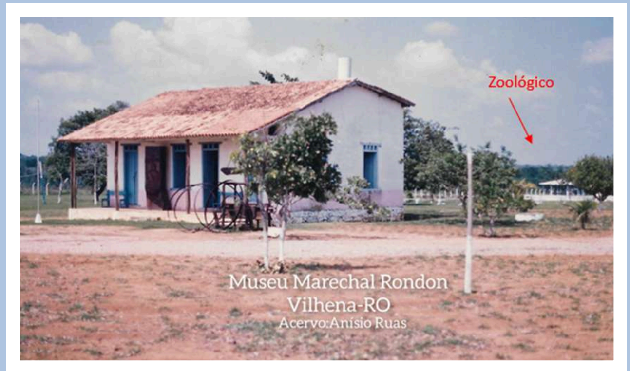
Figura 12: Sede do telégrafo em Vilhena - Anos 2010 antes da restauração Fonte: Acervo do Museu Casa de Rondon (2025)
