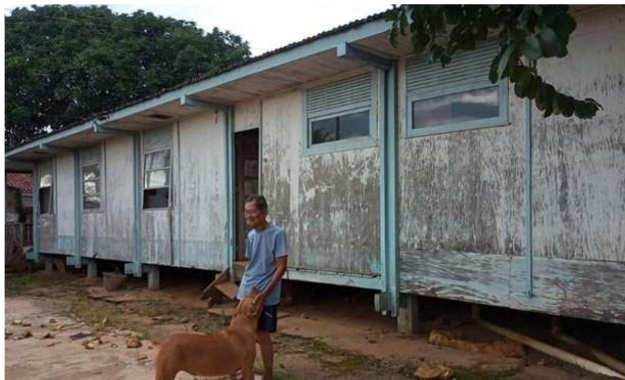
Figura 24: Casa que serviu de alojamento para os engenheiros da empresa Camargo Corrêa, responsável pela construção da BR-029. Fonte: Grupo do Facebook Memória Vilhenense (2024)
