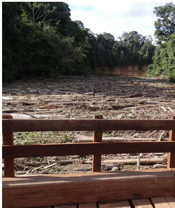
Ponte de São Carlos depois da enchente. Foto: Elissandra Ribeiro Ferreira da Silva
