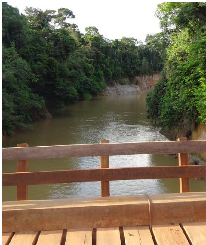
Ponte de São Carlos antes da enchente. Foto: Elissandra Ribeiro Ferreira da Silva
