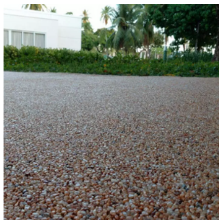
Figura 45- Piso fulget drenante resinado
