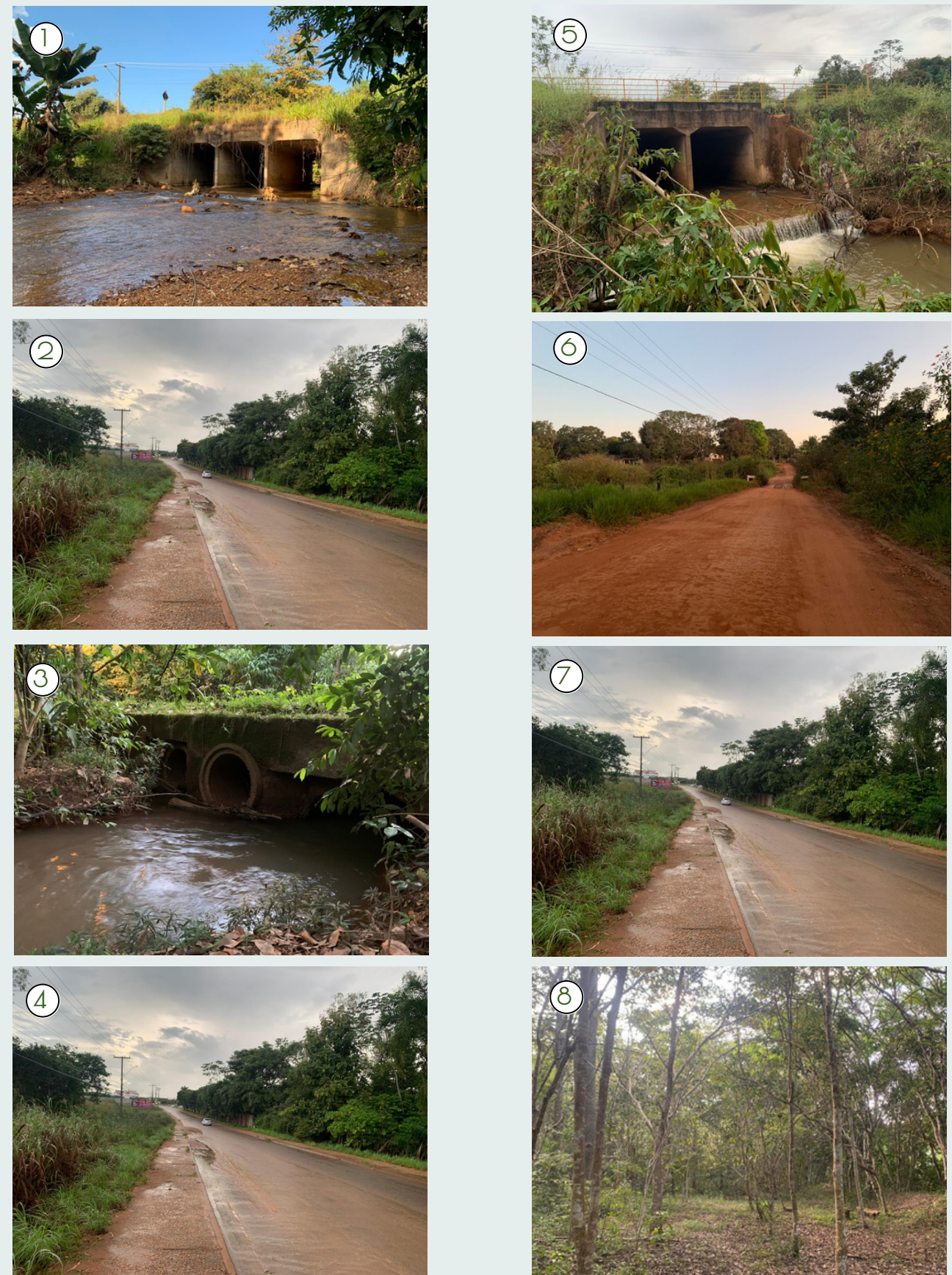
Figura 12 - Imagens das visitas in loco
