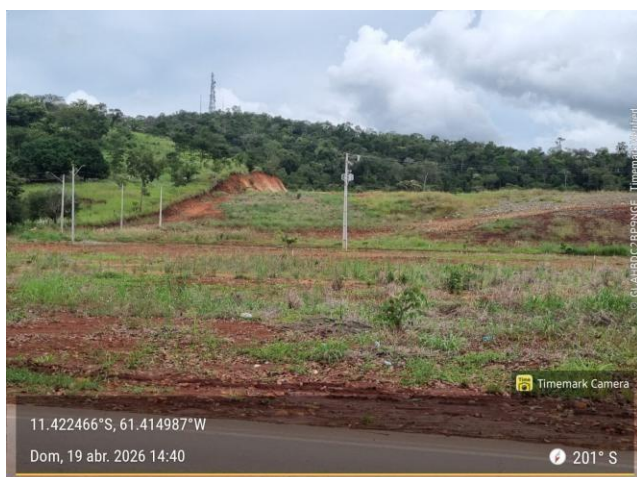
Figura 6 - Corte de talude.
