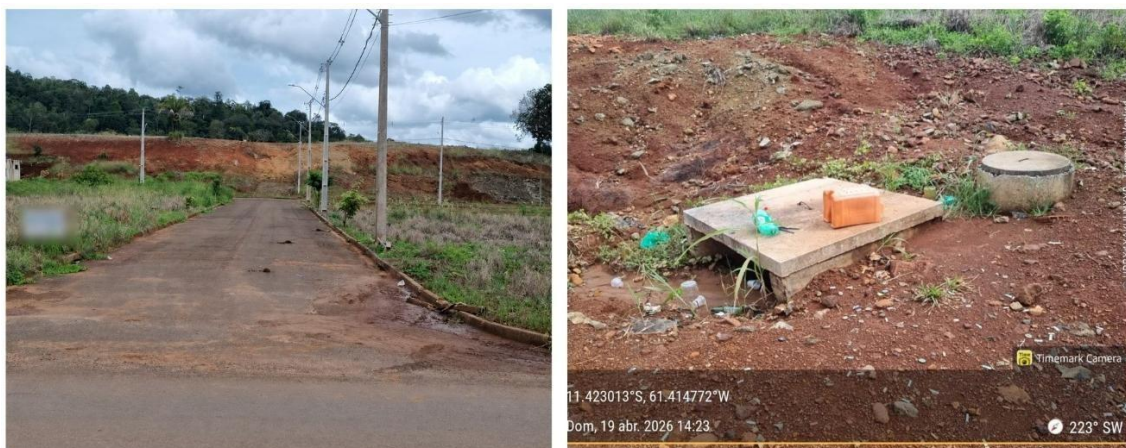
Figura 10 e Figura 11 - Abertura de vias, instalação de postes de energia e saneamento.
