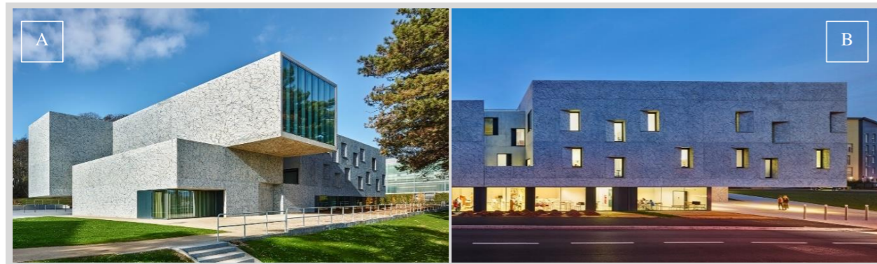
Figura 2 – Conservatório Henri Dutilleux
