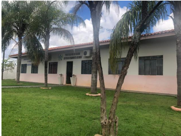
Figura 11: Fachada Norte - Administrativo
