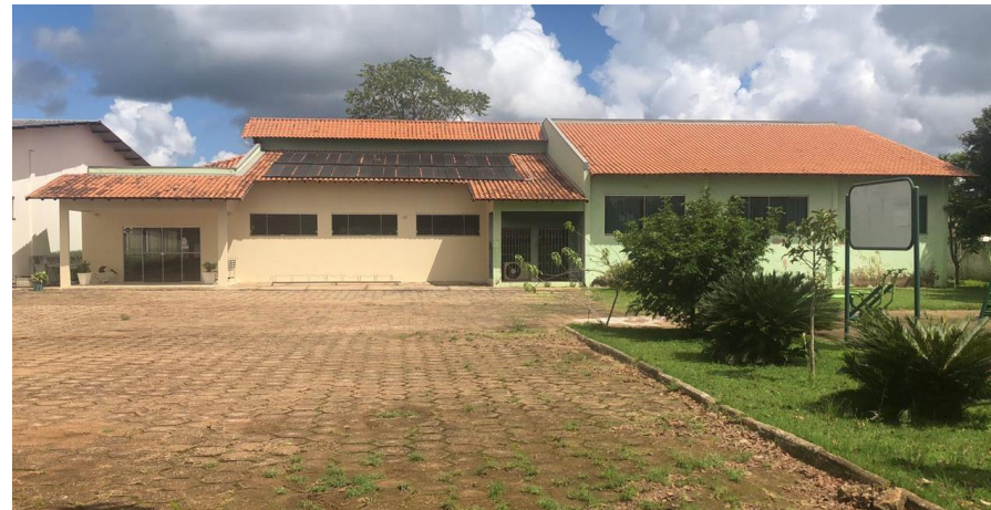
Figura 14: Fachada Centro de atendimento à saúde
