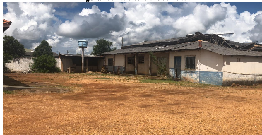
Figura 15: Pátio central da unidade
