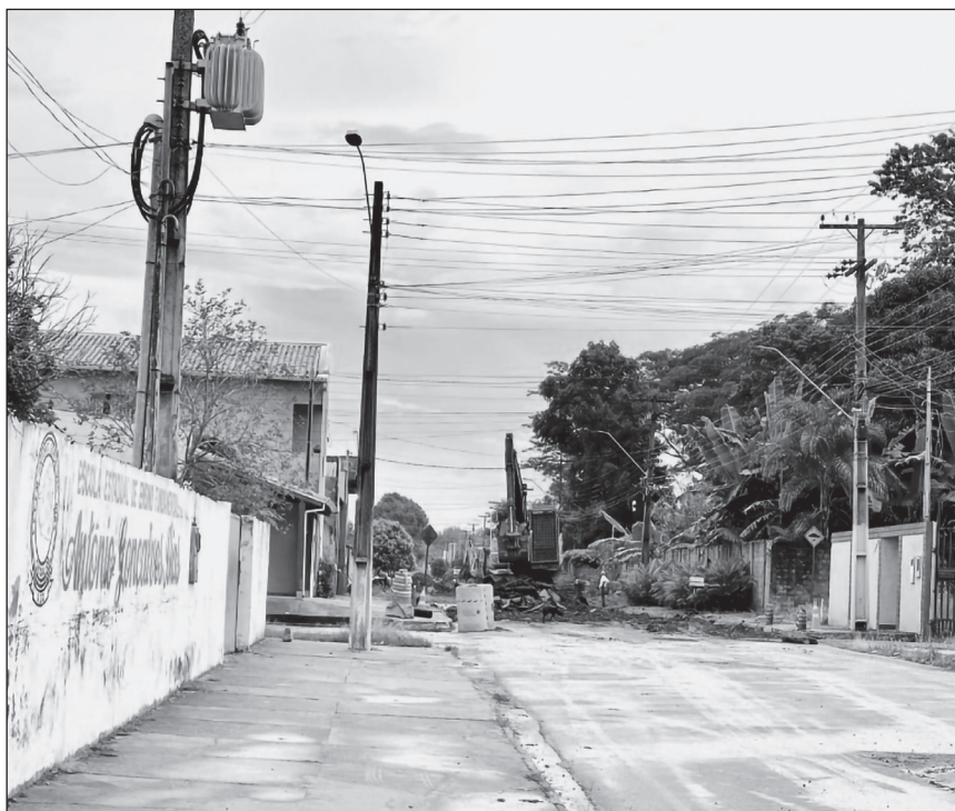
Imagem 3 – Obra do SAAE próximo a Escola
