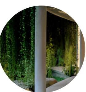
Figura 26 -Pilar redondo de concreto
