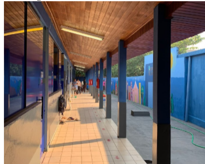
Figura 41 - Fachada centro de autismo
