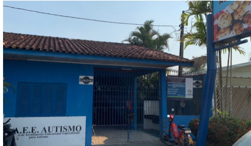
Figura 40 - Fachada centro de autismo
