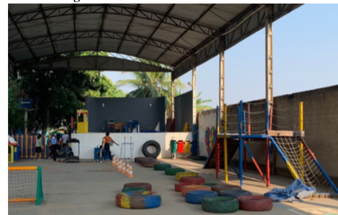
Figura 43 - Fachada centro de autismo
