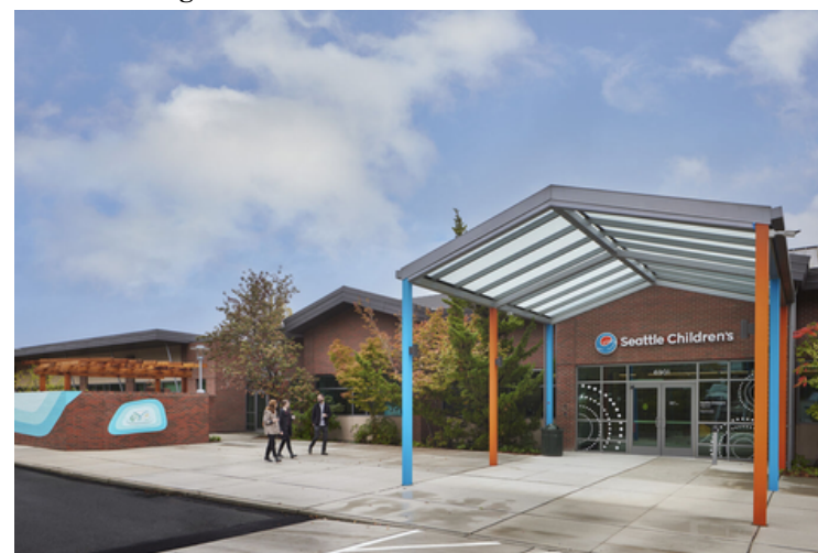
Figura 38 - Fachada centro de autismo
