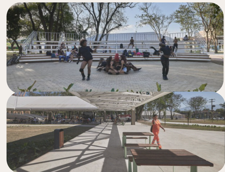
Figura 20 - Estrutura metálica arquibancada e cobertura
